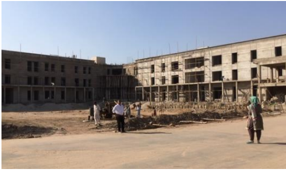
Dar Ul Sukun Rashidabad in aanbouw: 1000 bedden
